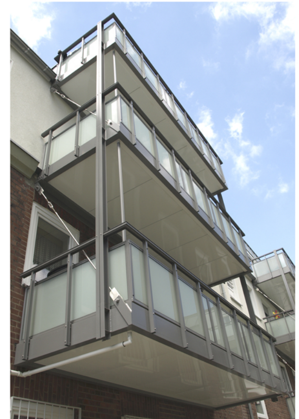
Foto: Detail Aluminiumbalkone
