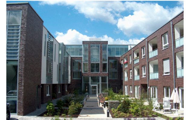
Foto: Nord-Ostansicht, Innenhof
