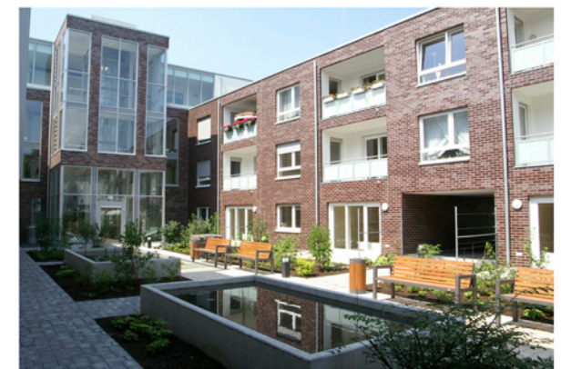
Foto: Ostansicht, Treppenhaus Hauptriegel und Wohnungen Querriegel 1
