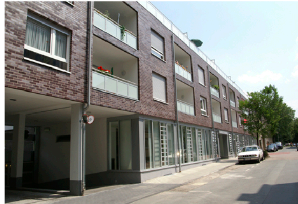
Foto: Süd-Westansicht, Straßenfassade - Hauptriegel
