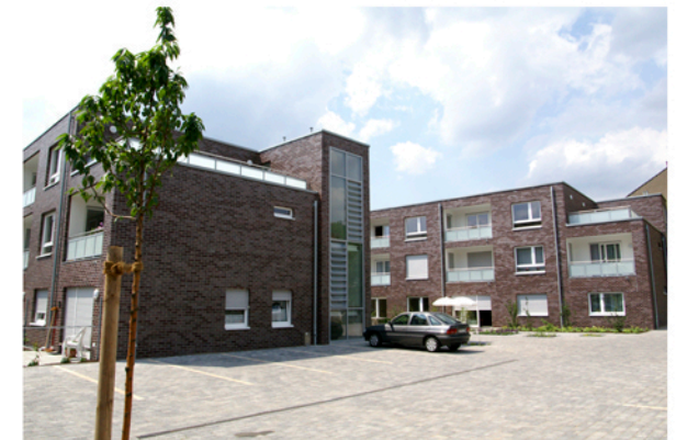
Foto: Ostansicht, Kopfseite Querriegel 2 mit Gemeinschaftsdachterrassen im II.OG
