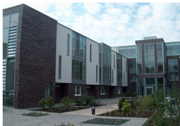
Foto: Nordansicht, Erschließungszone - Querriegel 2
