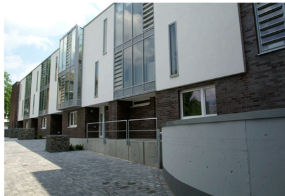
Foto: Nordansicht, Erschließungszone - Querriegel 1
