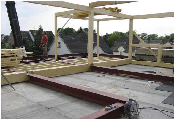
Foto: Bauphase - Richten der Tragwerkskonstruktion
