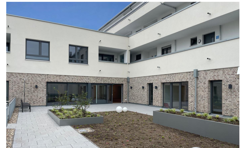
Dachterrasse Erdgeschoss - Demenz-WG
