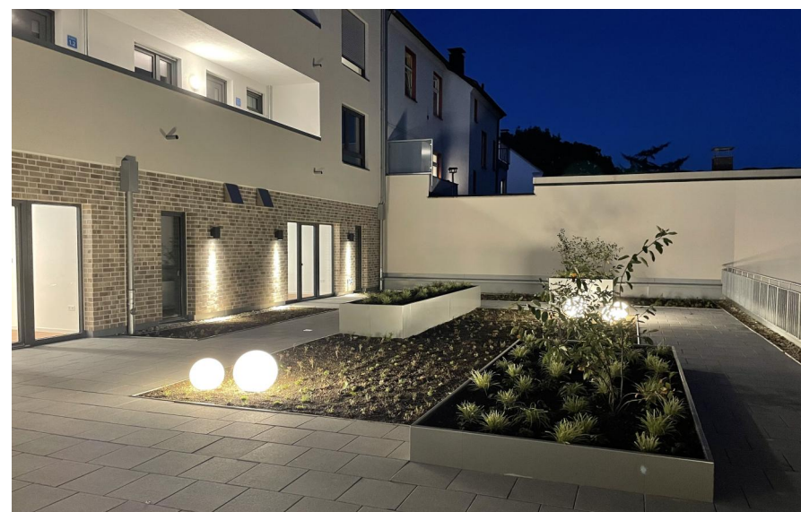
Dachterrasse Erdgeschoss - Demenz-WG
