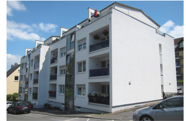
Foto: Straßenseite, nach der Sanierung
