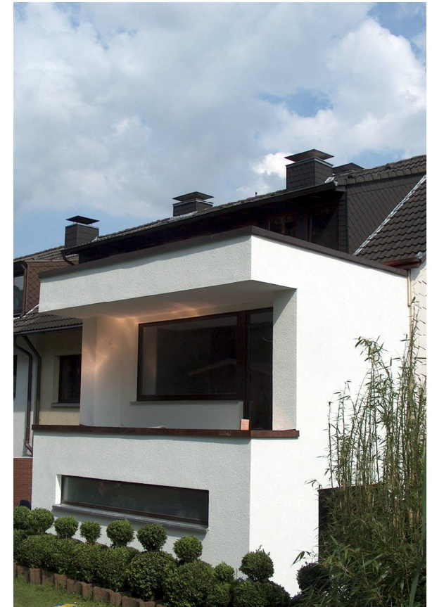
Foto: Gartenansicht Süd
