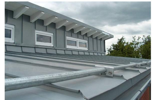
Foto: Detail Zinkverkleidung im versetzten Pultdachbereich
